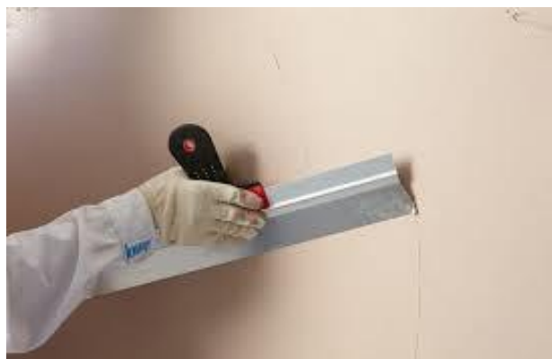
5.attēls. Apmetuma nogludinašana ar platu metāla špakteļlāpstiņu
