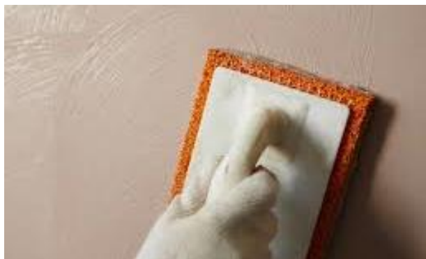
4.attēls. Ģipša apmetuma apstrāde ar švammes rīvdēli
