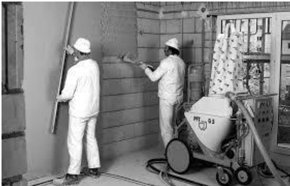
1.attēls. Mehānizēta javas uzklāšana
