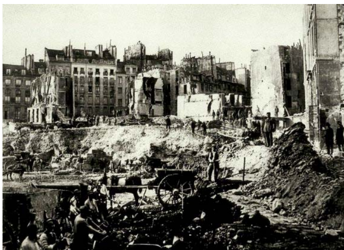
Veco būvju nojaukšana un jauno būvniecība. 1877.g
